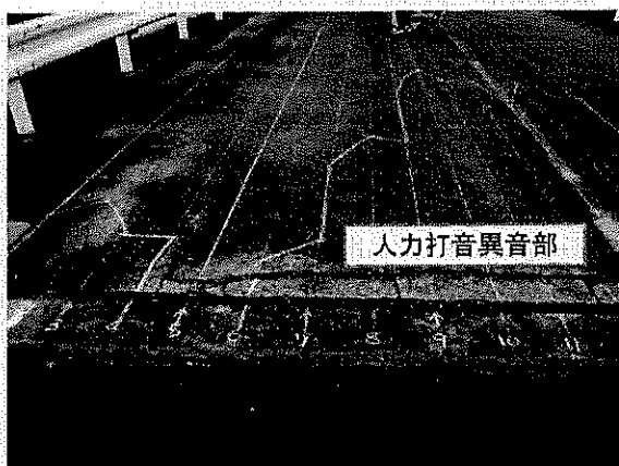
【人力打音測定異常部マーキング】
