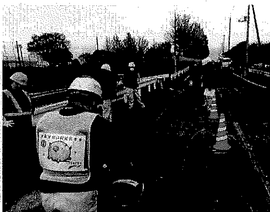
【回転式打音測定異常部確認状況】
