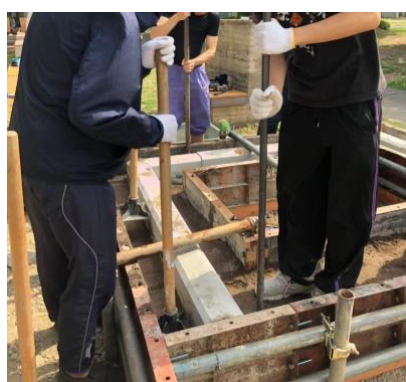
土を突き固めてつくる版築
